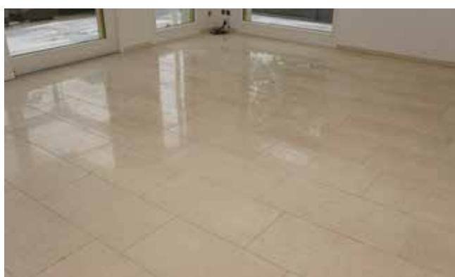
Bodenbelag nach Planschliff
