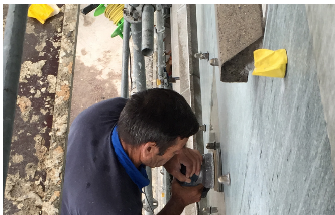
Anspruchsvolle manuelle Schleifarbeiten
