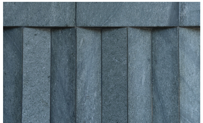
Granitplatten feingeschliffen und neu ausgefugt
