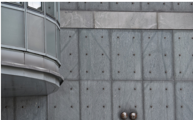
Stark verunreinigte Metallpanelen und Steinplatten
