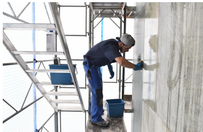
Mitarbeiter beim Auftragen des Reinigungsgels
