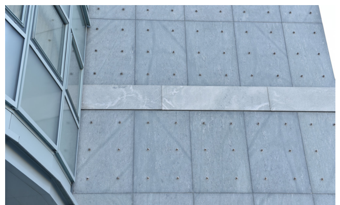
Fassade in neuem Glanz
